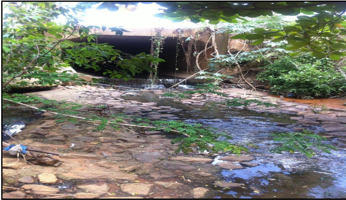
Figura 13. Punto #1, unión de canal colector con el cauce natural.
