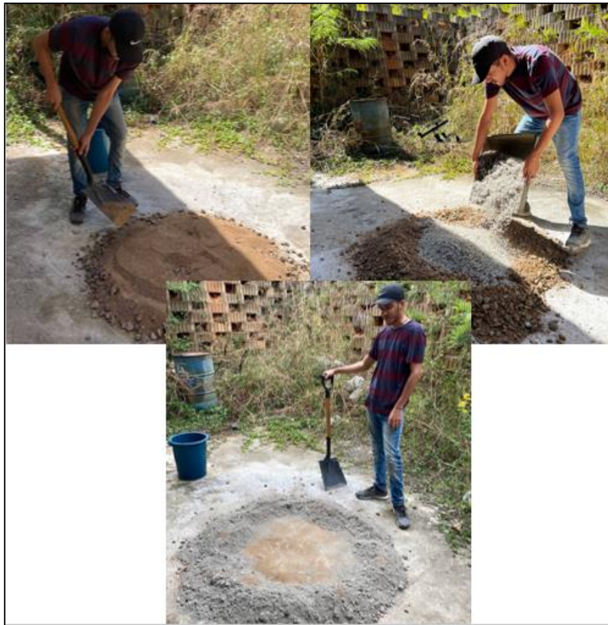
Figura 67. Preparación de mezcla de concreto con sustitución por material polimérico Tomada por Perdomo, 2023, Venezuela. Derechos reservados por autor.
